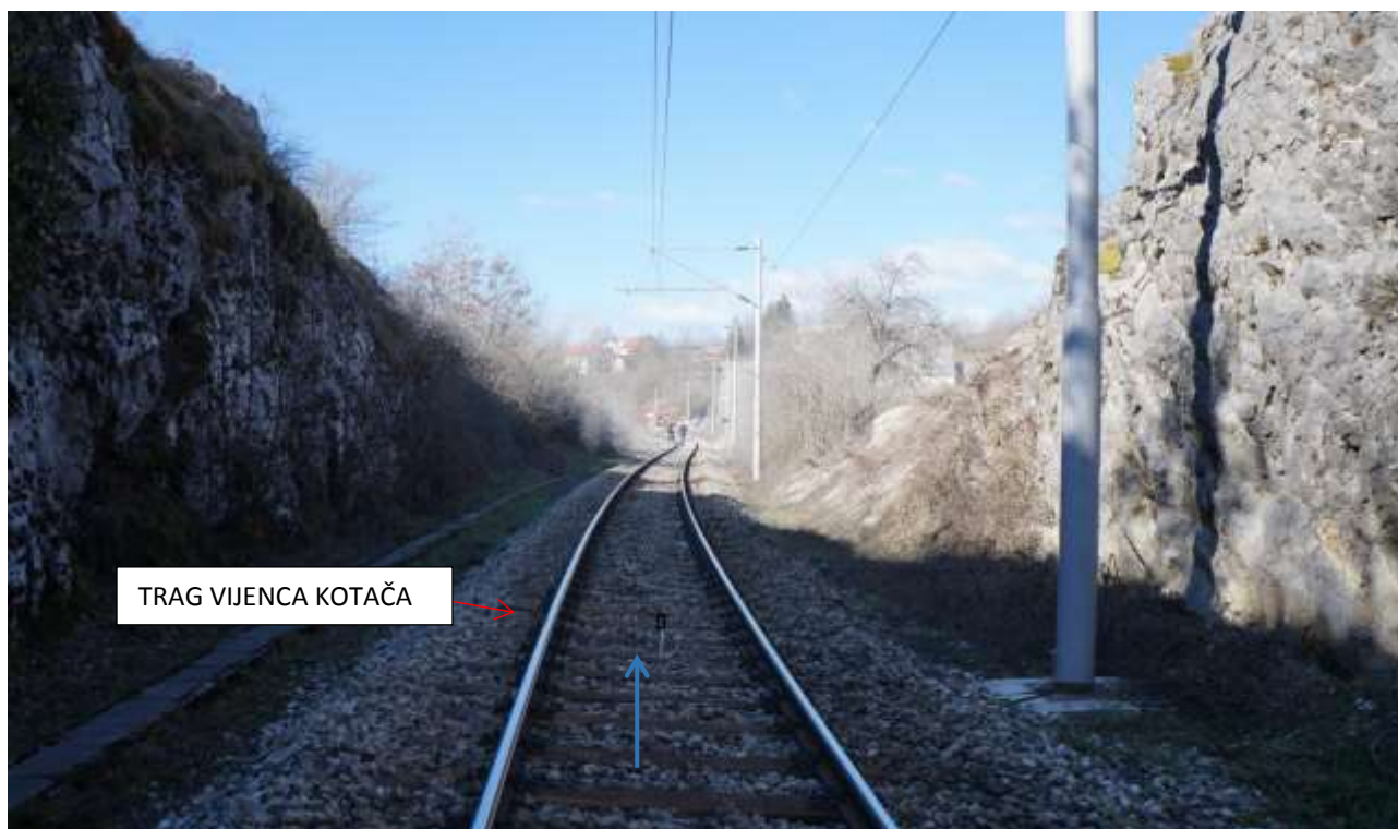
Slika 5. – Bliži snimak mjesta iskliznuća (izvor slike: AIN)
