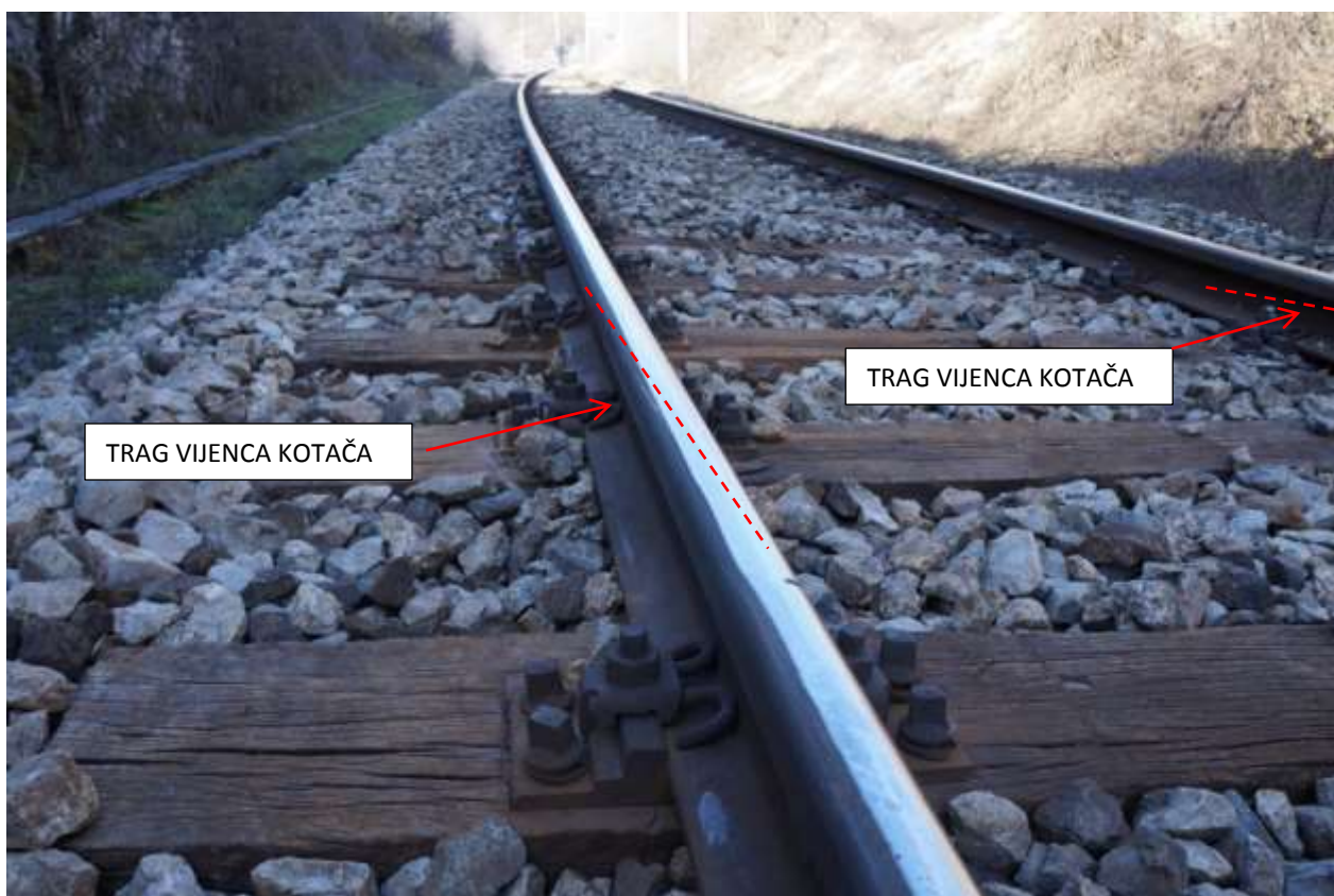
Slika 6. – Detalj mjesta iskliznuća, lijeva tračnica (izvor slike: AIN)
