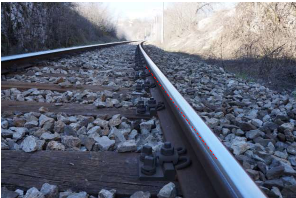
Slika 7. – Detalj mjesta iskliznuća, desna tračnica (izvor slike: AIN)
