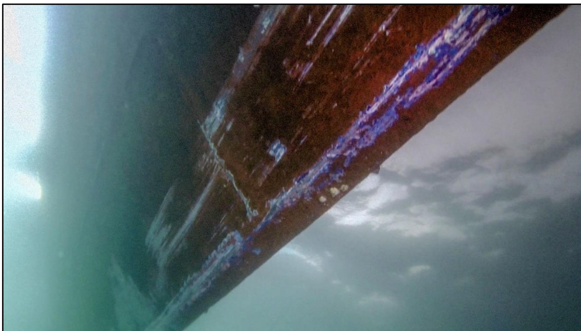
Slika 5. Dio oštećenja na pramčanom dijelu oplata lijevog trupa (izvor: NEPTUN SUB d.o.o., za ronilačke radove i hidroiženjering)
