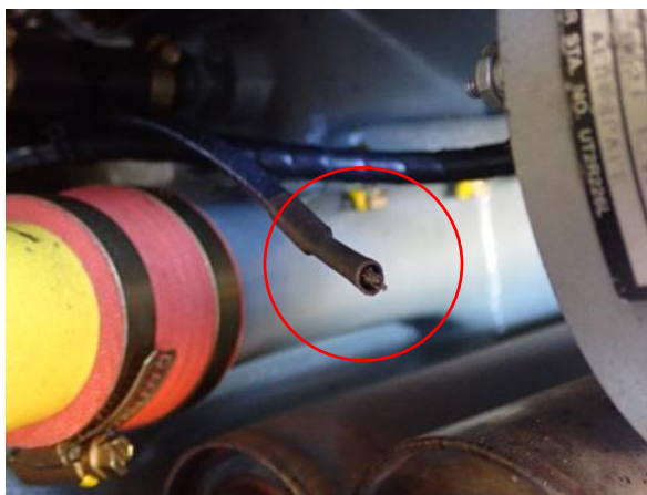
Slika 21 – Odvojena žica pobude alternatora od kontakta
