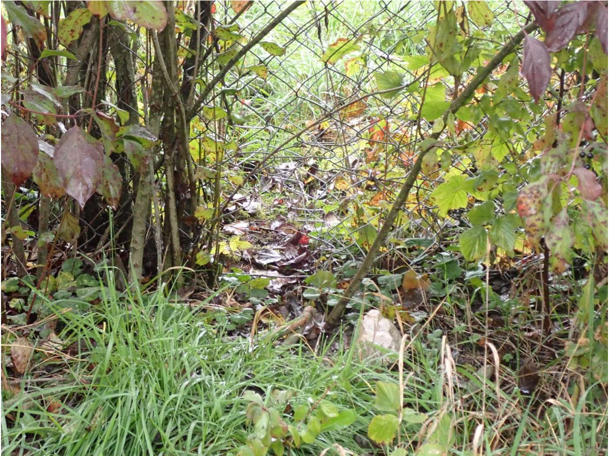
Slika 8. – Oštećenje (rupa) u ogradi oko Aerodroma Lučko i vegetacija u koju su neki dijelovi ograde zarasli
