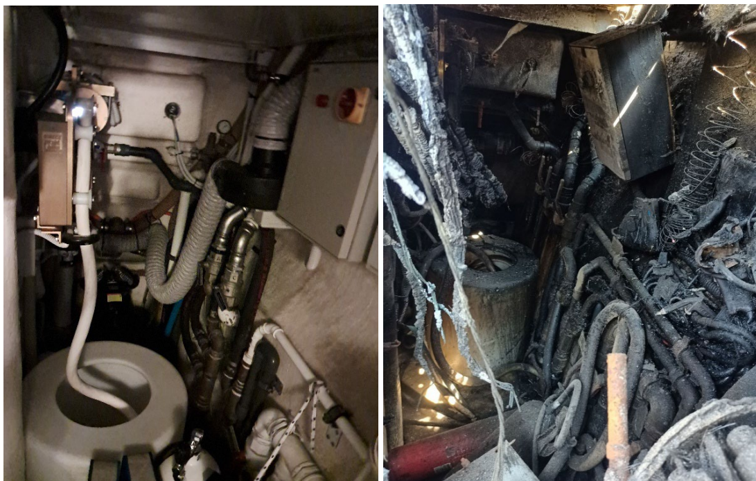
Slika 5. Tehnički prostor – krmeni dio, na jahti-blizancu (lijevo) i na opožarenoj jahti (desno) (izvor: AIN 1 )
